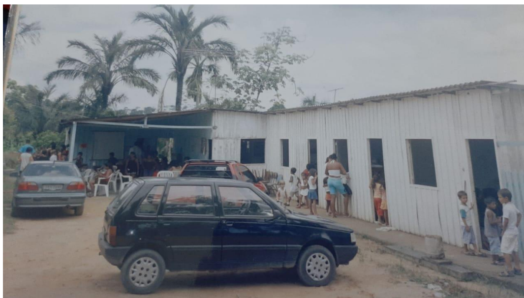
Figura 1 – Primeiro prédio construído
